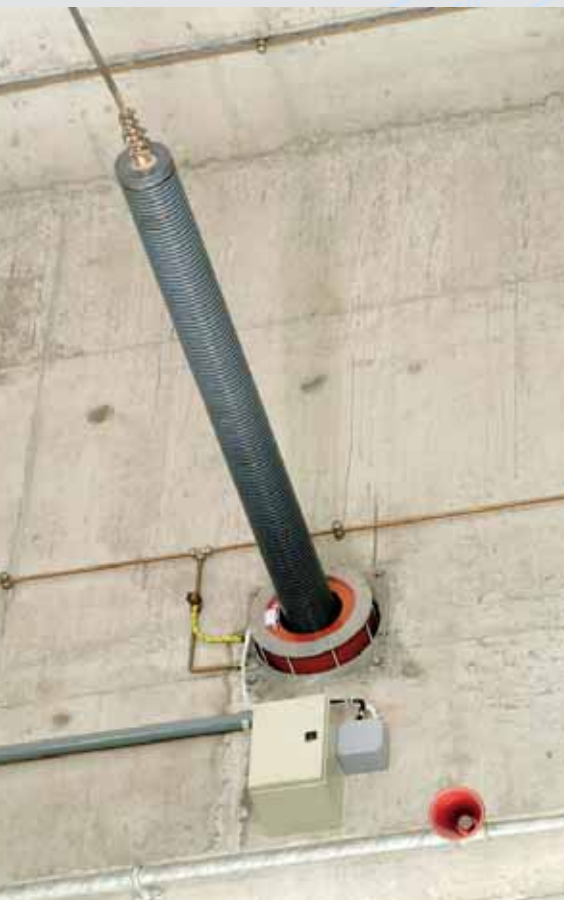
Wanddurchführung Wall bushing Traversée murale 145 kV - 400 A HS Station von La Foretaille, SIG HV substation of La Foretaille, SIG Poste HT de La Foretaille, SIG
